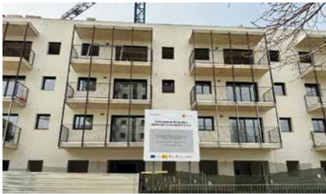
Façana d'una promoció d'habitatges públics en fase final de construcció al carrer Alt de Sant Pere de Montcada i Reixac.
