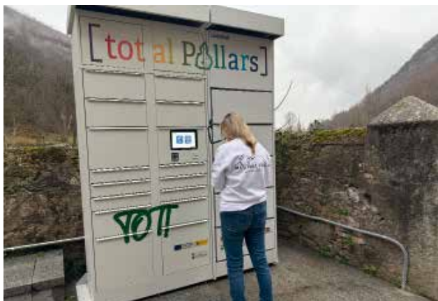
Armariets intel·ligents a la Torre de Cabdella.
