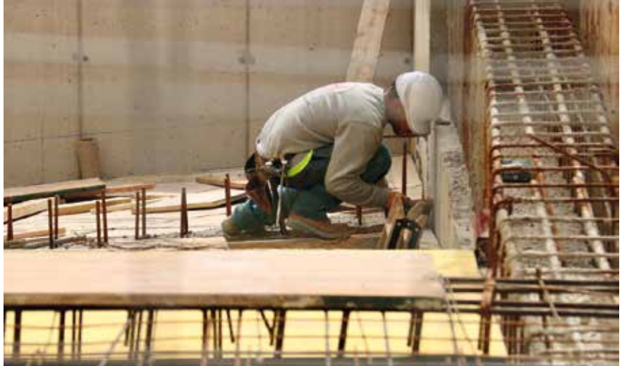
Un operari treballant en una promoció d'habitatges públics en construcció al carrer Alt de Sant Pere de Montcada i Reixac.
