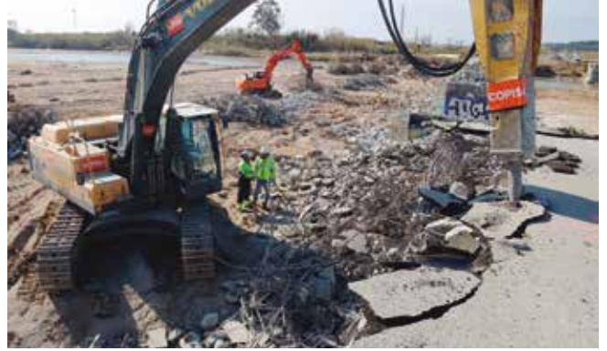
Inici de les obres de retirada del pont de la Tordera malmès pel temporal Gloria Imatge del 26 de febrer de 2020. Foto: Jordi Pujolar
