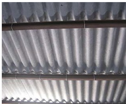
Vista inferior de cubierta de fibrocemento con estructura metálica en buen estado de conservación. Fuente: Sección de Prevención de Riesgos Laborales. ISPLN.
