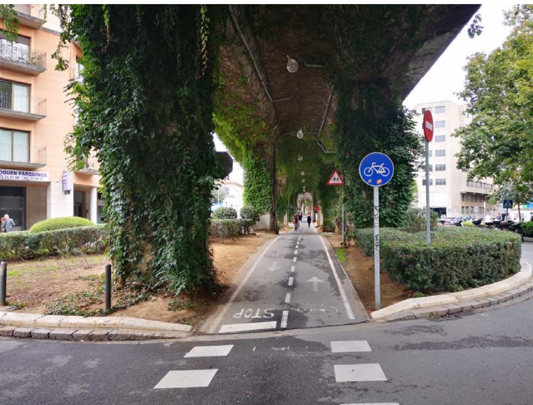
Via elevada del tren. Girona
